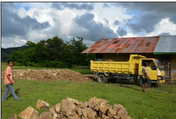
校舎の建設予定地に石が運び込まれました。
