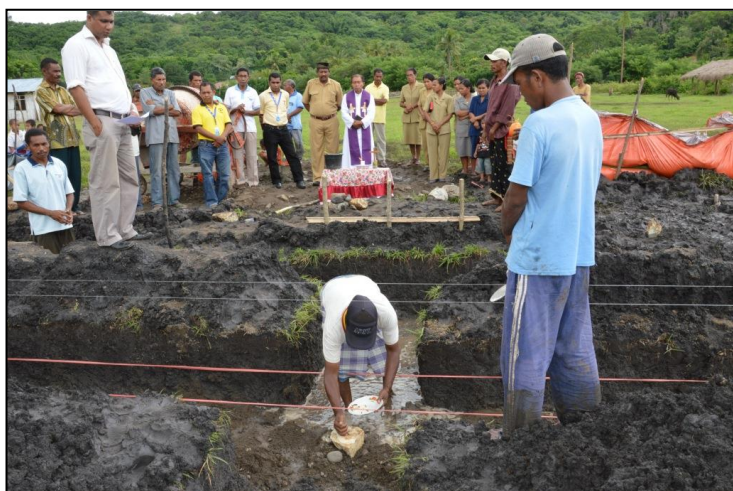
校舎の建設予定地での着工式
